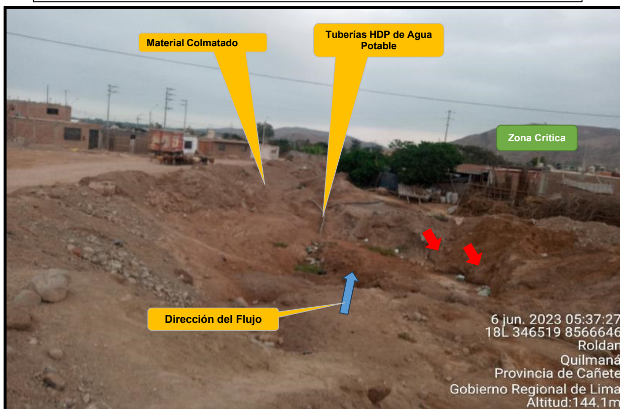
FIGURA N°03: CAUCE DE LA QUEBRADA ROLDAN, DONDE PASA POR UNA PARTE DE LA CIUDAD, DONDE SE MUESTRA LA INSTALACION DE AGUA POTABLE, ESTE SUCEDA CUANDO LA QUEBRADA SECA DE ROLDAN SE ACTIVA EN MAXIMAS AVENIDAS.
